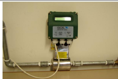
Un misuratore di portata elettromagnetico montato su una condotta
